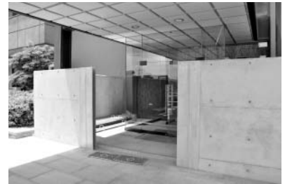
朝田浄水場の浸水対策
