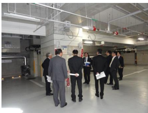
神戸市危機管理センターの免震構造
